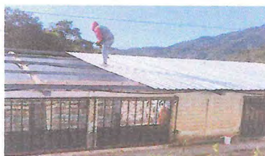
Foto 4: Avances del techado.
