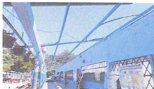
Foto 2: Limpieza de estructura.
