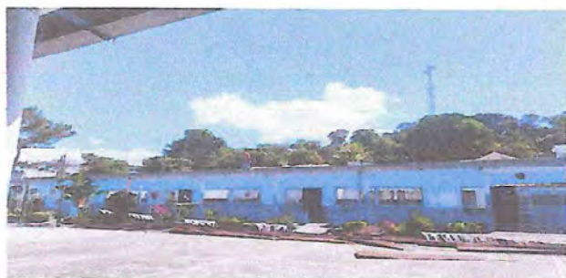
Foto1: Iniciación de los trabajos
