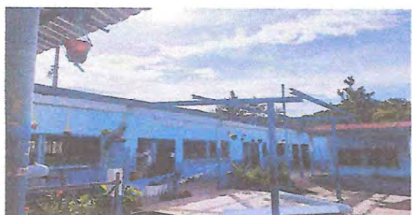
Foto 3 Limpieza de estructura de la segunda área a remozar.
