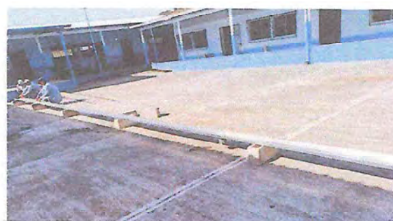
Foto 6: Soldadura de canales
